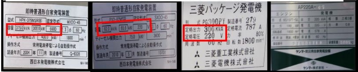
発電機の内側にある銘板例（上と下は同一の発電機のものです。）
